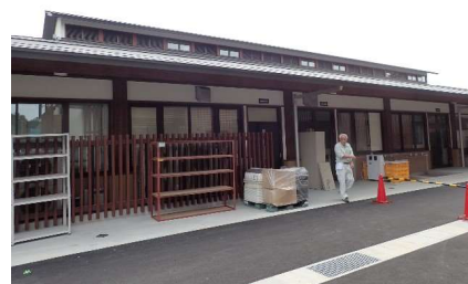
現場管理棟の事務所
